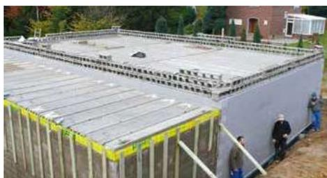
**N.B. :** Dans la pratique, cette coupe des isolants (pour les araser avec le béton du plancher) est rarement précise.
