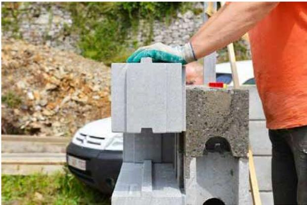
**Rappel :** Les blocs isolants doivent être emboîtés après la pose de chaque lit de blocs béton.
