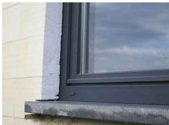
N.B. : Avec les blocs isolant en EPS graphité plus épais (30 cm, voire 20 cm il est possible de les entailler de façon à placer les chassis davantage vers l'extérieur.
