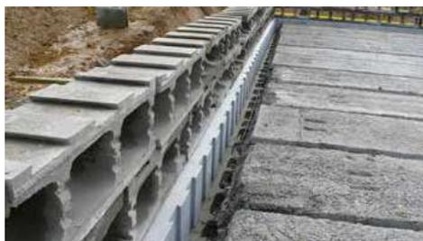
Avant la pose du premier lit de bloc béton de l'étage supérieur, il y a lieu de couper la partie dépassante (en rouge sur le croquis ci-dessous) du bloc isolant.
