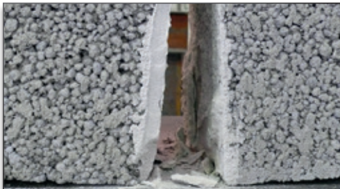
De mortelvoeg is de zwakke schakel van het metselwerk
