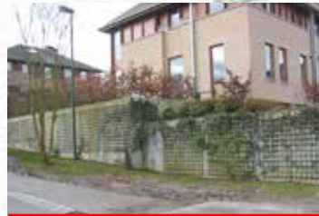
Murs de soutènement
